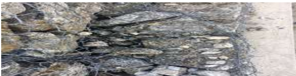
Fig:e 18.1: Mesh wires tornoff
