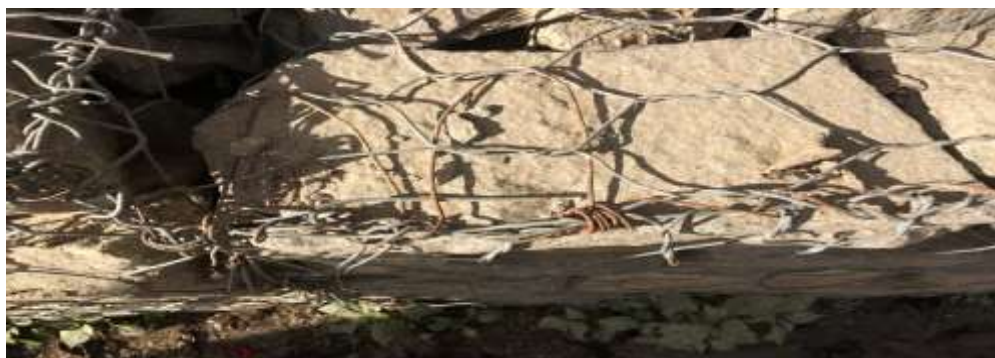
Fig: 14.1: Rusted mesh wire
