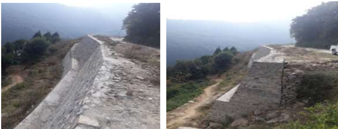
Para 8.5- Restored Damaged R/wall
