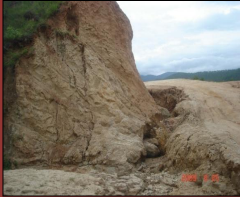
Silipang-Logoda road: Drain gone wrong (Punakha)
